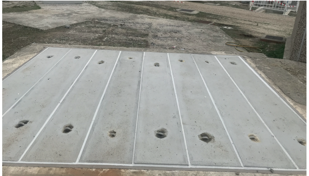
Cobijas depósitos de agua potable
