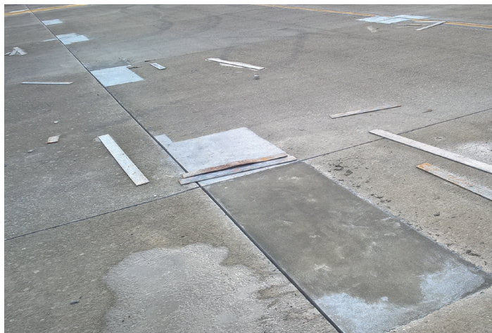
Detalles de las distintas fases de la reparación de las losas
