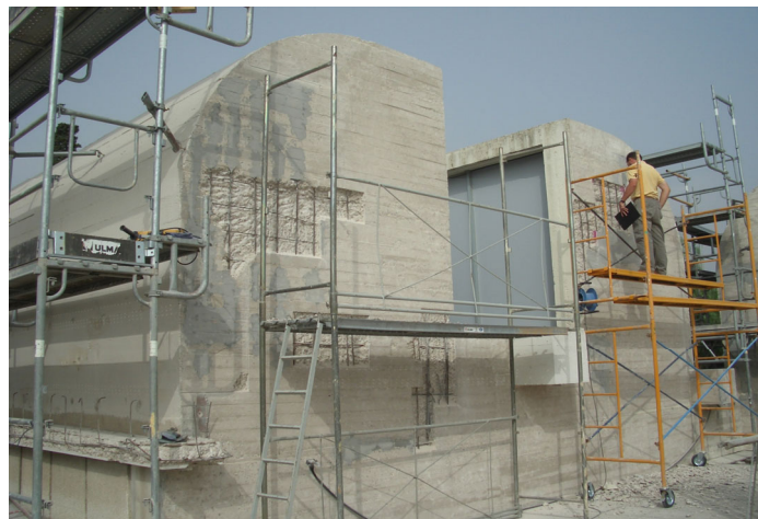
Trabajos de medición y reparación
