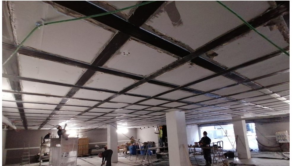
Sistema de refuerzo MasterBrace LAM aplicado
