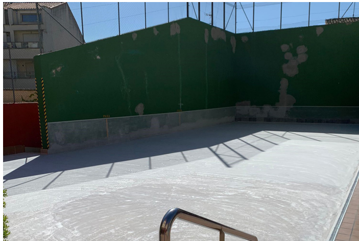
MasteTop 1324 en suelo con MasterTop TC 445 en paredes
