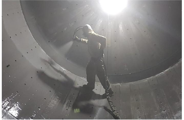
Imprimación con MasterSeal P 770 y capa final con poliurea pura MasterSeal M 689 en espesores de hasta 12 mm
