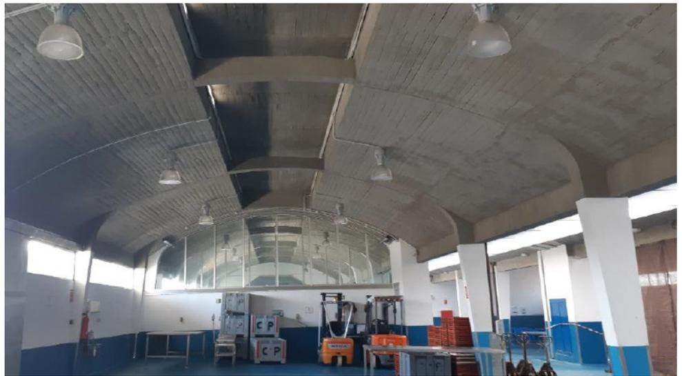
Inferior forjado protegido con inhibidor base silano MasterProtect 8000 CI y con revestimiento MasterProtect 126 Grey.
