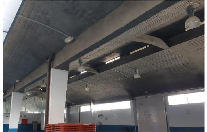
Una vez se repara, se protege con inhibidor de corrosión migratorio base silano y con acabado mediante realcalinizador del hormigón
