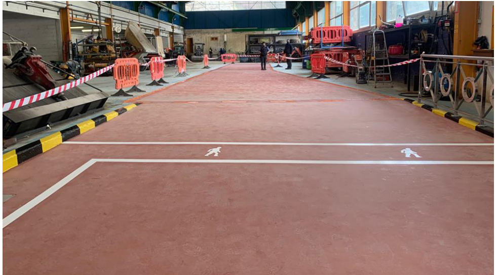
Adecuación pasillo de hormigón
