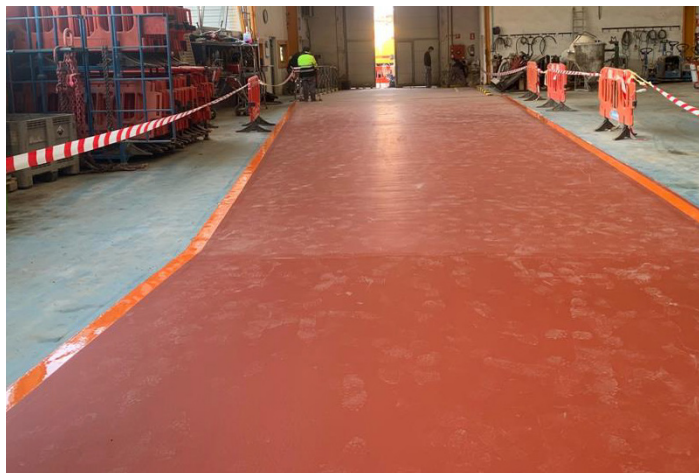
MasterTop 1273: Readecuación pavimento en bar de Bilbao
