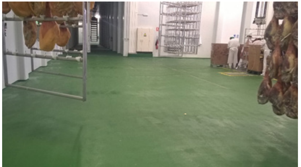
Zona revestida con Ucrete DP 10 verde en 6 mm de espesor
