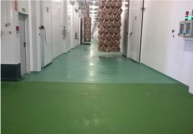
Zona revestida con Ucrete DP 10 en 6 mm verde y MasterTop 1221
