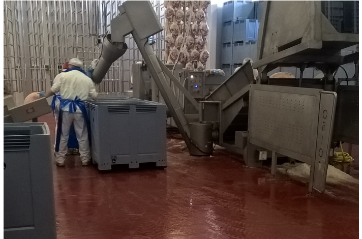
Zona revestida con Ucrete DP 10 rojo en 6 mm
