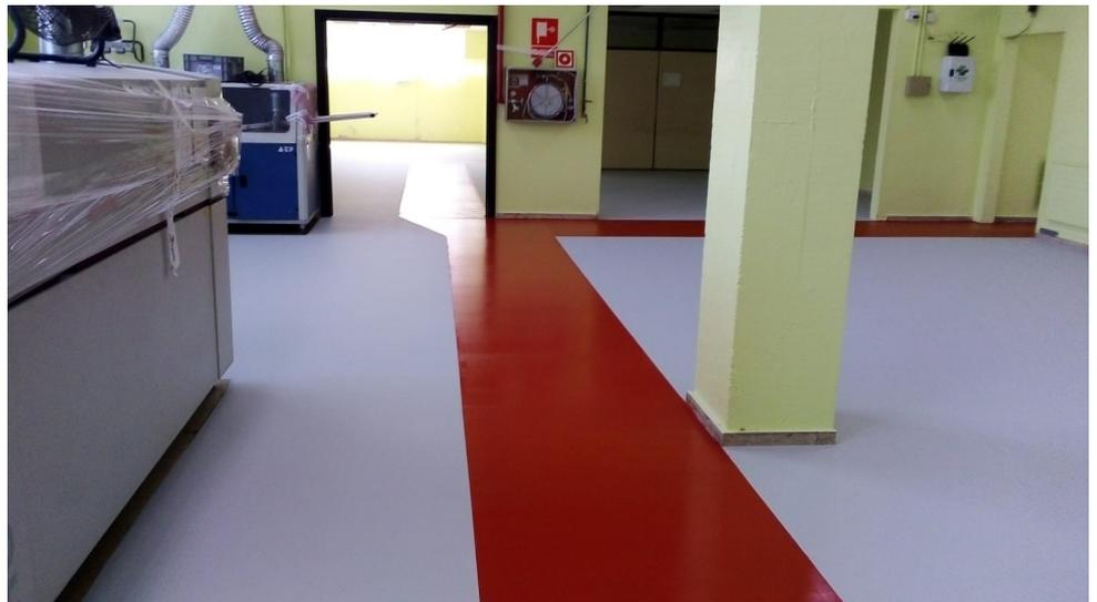
Imagen sala de producción de chips. Pavimento conductivo
