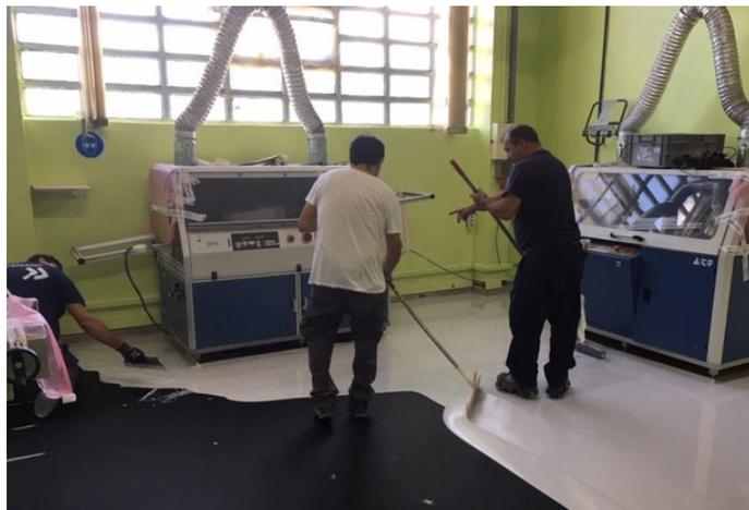
Aplicación del pavimento conductivo
