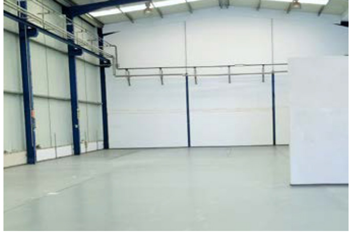
Pavimento Ucrete DP 10 continuo antes de la colocación de la maquinaria
