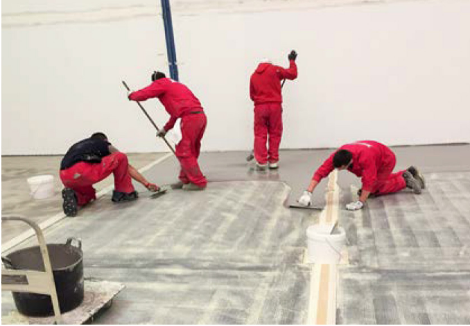
Proceso de aplicación del sistema Ucrete DP 10 acabado Gloss
