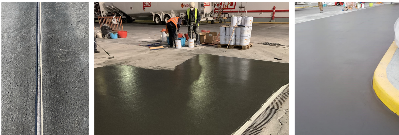
Ejecución de la junta y del pavimento y aspecto del acabado final.
