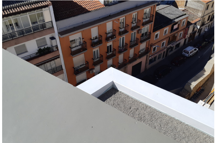
Prueba de estanqueidad y zonas con acabados del Sistema MasterSeal Roof 2103
