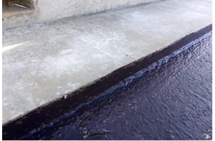
MasterSeal M 452: Impermeabilización nuevo puente Orona
