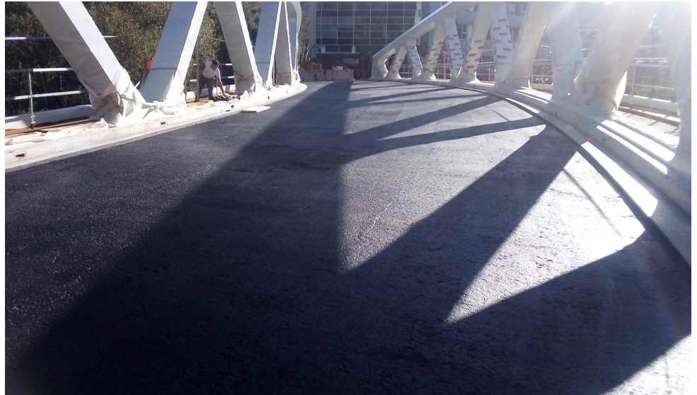
MasterSeal M 452: Impermeabilización nuevo puente Orona
