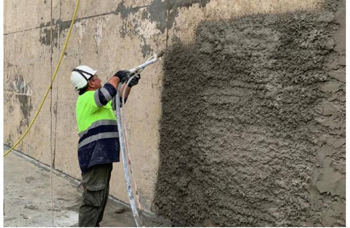
Trabajos previos de reparación: aplicación del protector de armaduras MasterEmaco P 5000 AP y del mortero de reparación estructural MasterEmaco S 5300
