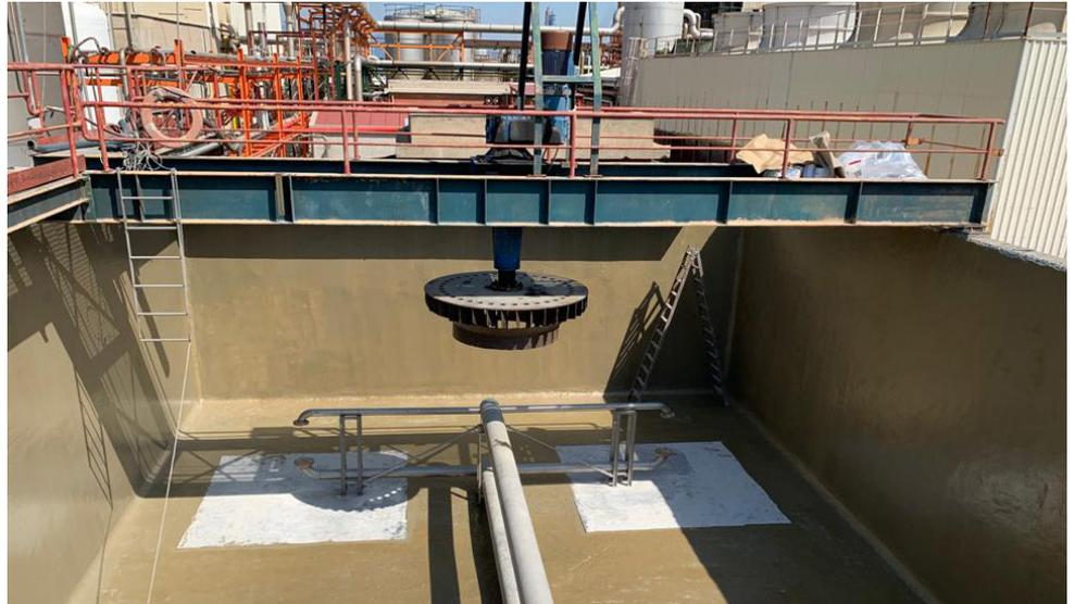
Aspecto que presenta el reactor tras los trabajos de reparación e impermeabilización con MasterSeal 7000 CR
