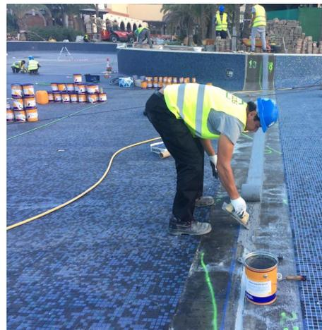
Impermeabilización con MasterSeal 550 y sellado de juntas con MasterSeal
