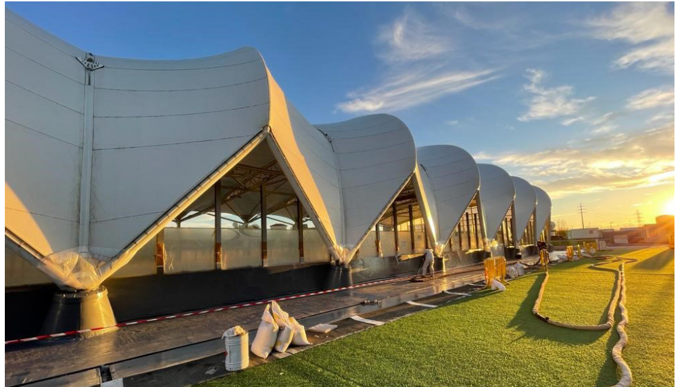
Impermeabilización MasterSeal Roof 2111: Cubierta parking en instalaciones deportivas UNEATLANTICO
