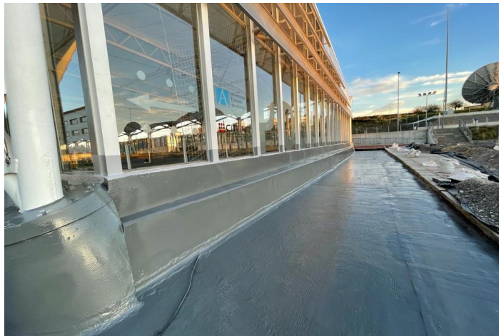
Impermeabilización MasterSeal Roof 2111: Cubierta parking en instalaciones deportivas UNEATLANTICO
