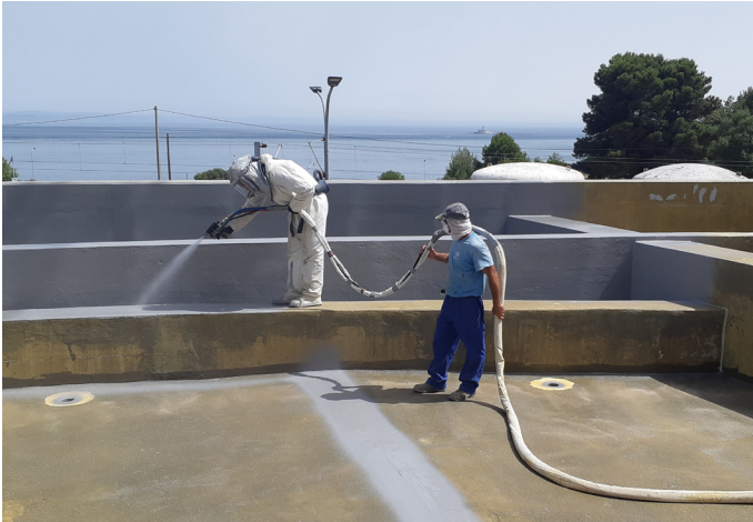
Proyección de poliurea pura en caliente MasterSeal M 689 sobre soporte imprimado y aspecto del acabado final en zonas de geometría compleja
