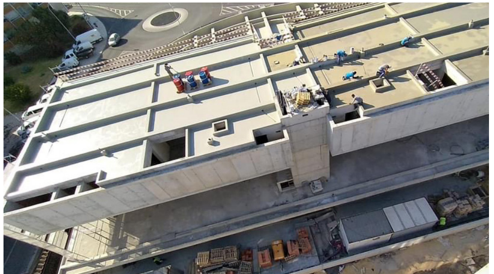
Impermeabilización de piscinas en cubierta con poliurea pura proyectada en caliente MasterSeal M 689
