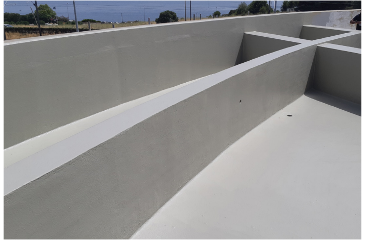
Proyección de poliurea pura en caliente MasterSeal M 689 sobre soporte imprimado y aspecto del acabado final en zonas de geometría compleja
