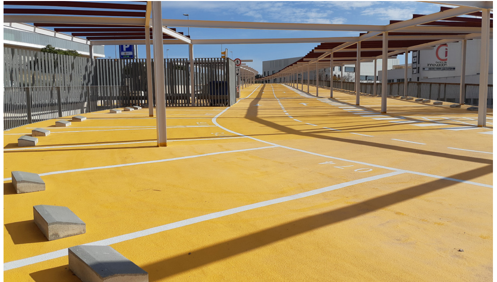
Vista de la cubierta parking impermeabilizada
