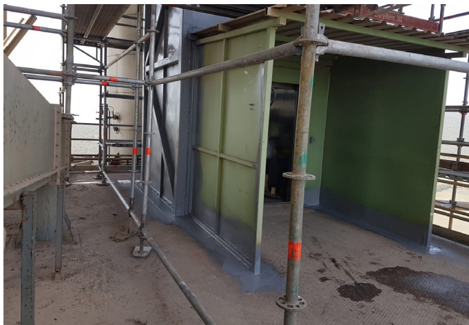
Sellado con masilla MasterSeal NP 472 e impermeabilización con Sistema MasterSeal M 6689 en base a poliurea pura MasterSeal M 689
