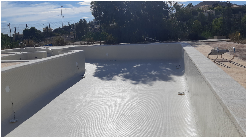
Alicatado y rejuntado de los distintos vasos de la piscina de poliéster
