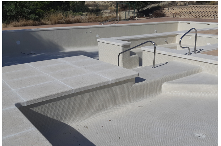
Alicatado y rejuntado de los distintos vasos de la piscina de poliéster
