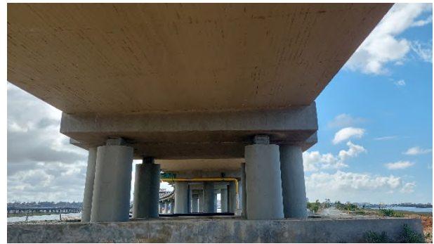
Protección pilas Puente Sifón (Huelva)
