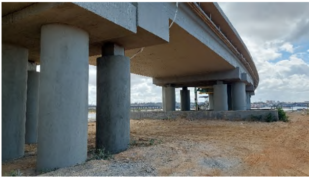
Protección pilas Puente Sifón (Huelva)
