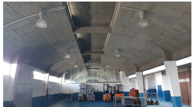
Protección cara inferior forjado loja Sanlúcar de Barrameda
