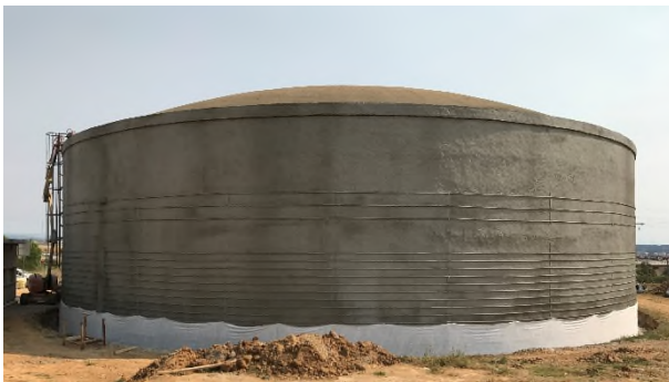
Protección exterior depósito agua potable (León)
