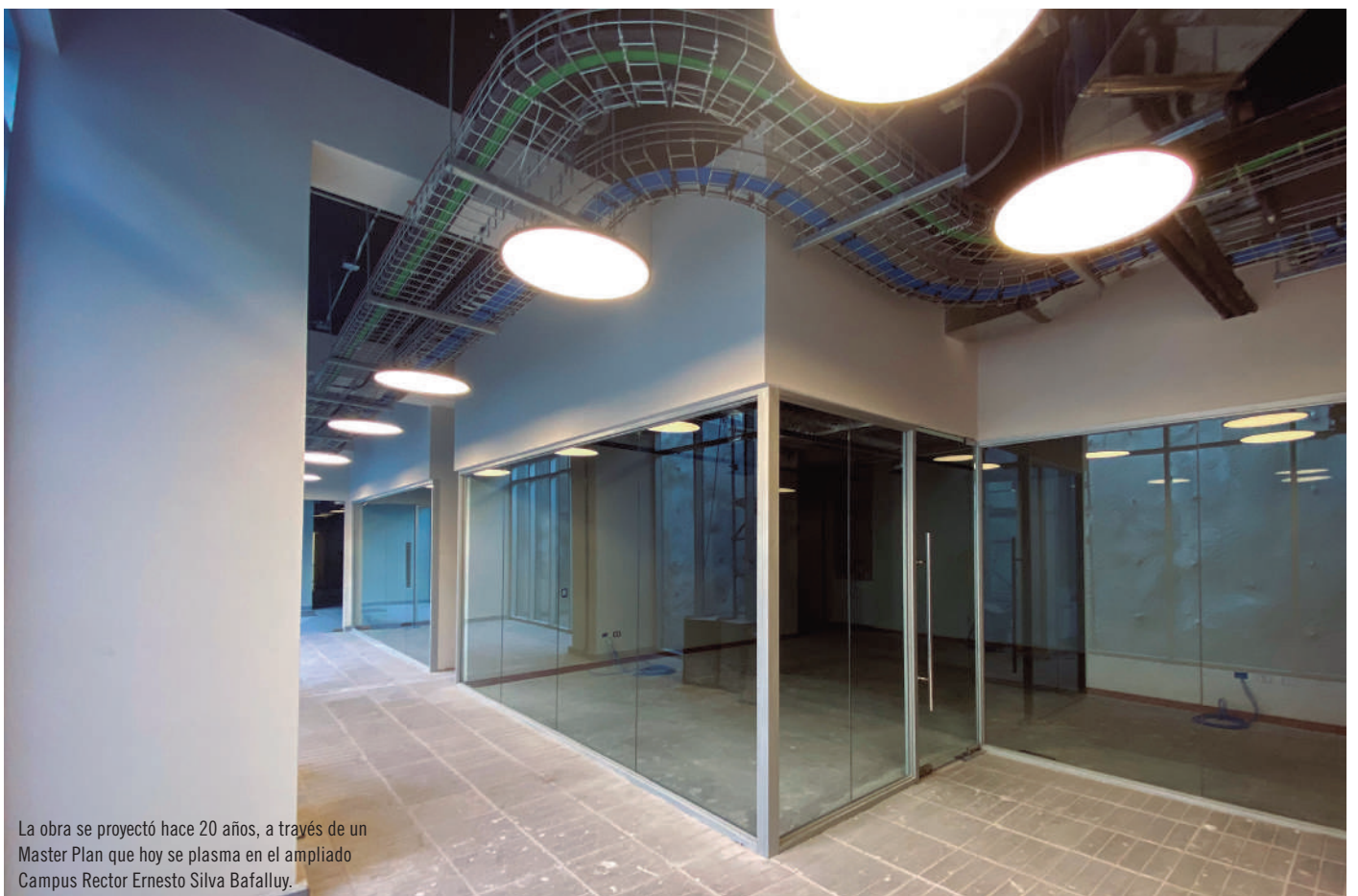
La Facultad de Medicina Clínica Alemana-UDD se instalará en el Edificio Oriente. Se emplaza en una elevación del centro del campus frente a su jardín principal.
