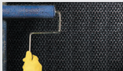
5. Oprima la lámina de fibra seca contra el saturante húmedo. Pase un rodillo nervado (desespumante) para oprimirla contra la superficie. Aplique una segunda capa de saturante para permitir el encapsulado completo de las fibras.
