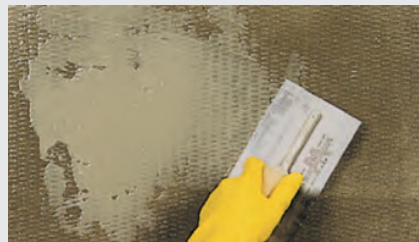
2. Aplique la pasta utilizando una llana para emparejar superficies desiguales.
