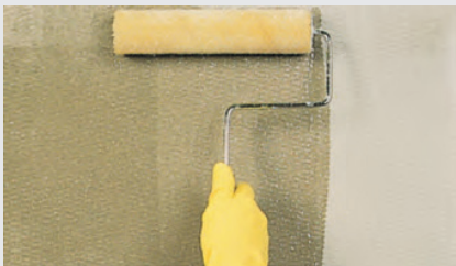
1. Aplique el primario superficial utilizando un rodillo medio.
