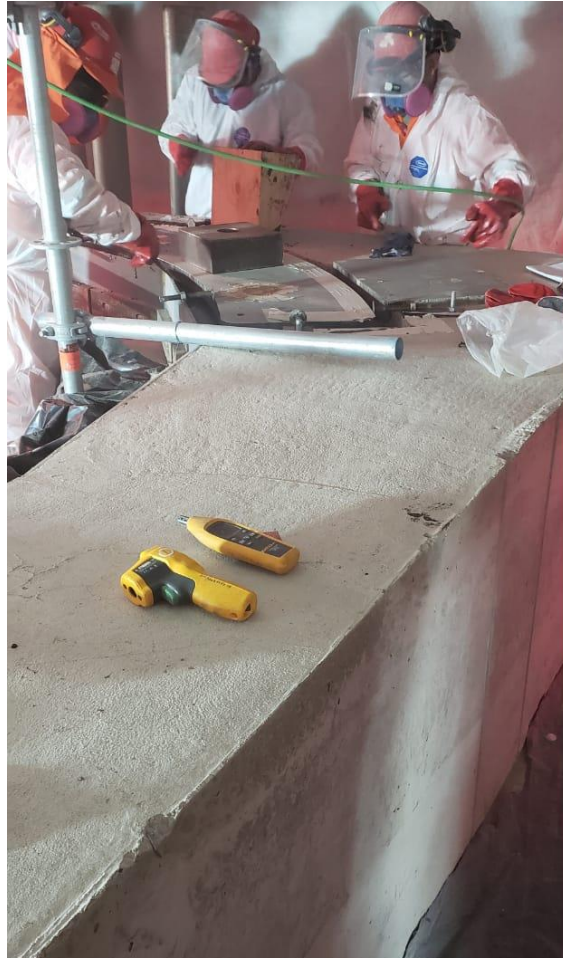
Aplicación MasterFlow 648 CL, Proyecto Quebrada Blanca 2.
