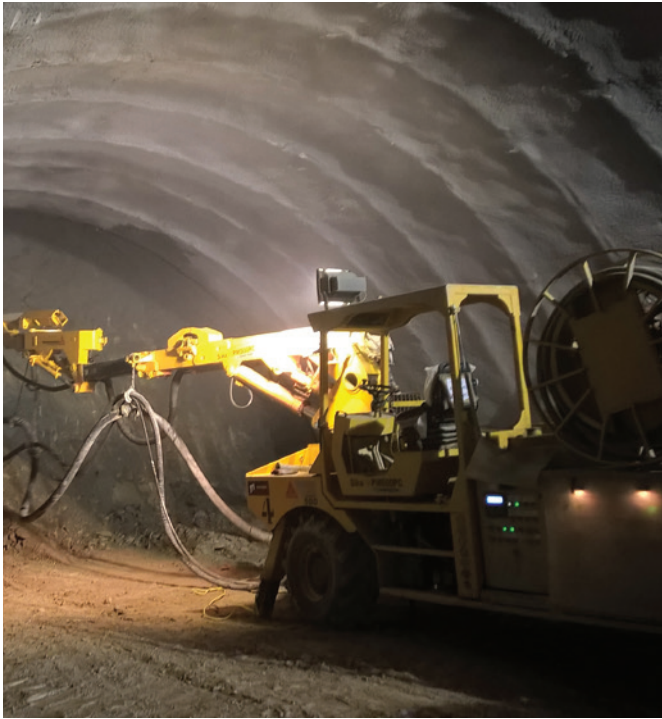
MasterFiber Autovía B-40, Barcelona
