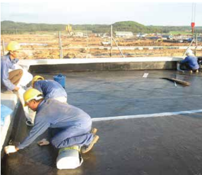
Nhà máy lọc dầu Dung Quất - Quảng Ngãi
