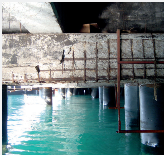
Spalling
