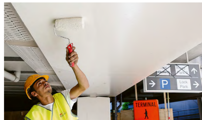
Manueller Auftrag von MasterProtect 330 EL (Parkhaus Flughafen Brüssel, Belgien)
