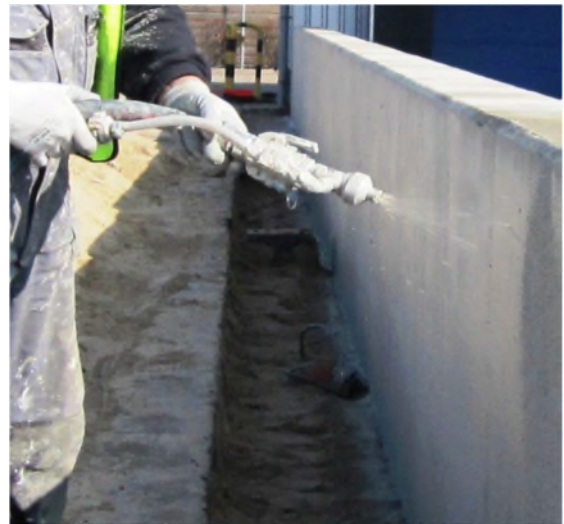
Aufspritzen von MasterSeal 6100 FX
