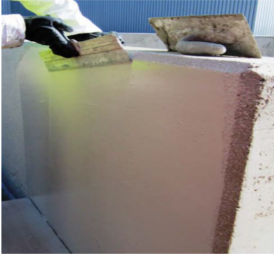
Oberflächenbehandlung von MasterSeal 6100 FX
