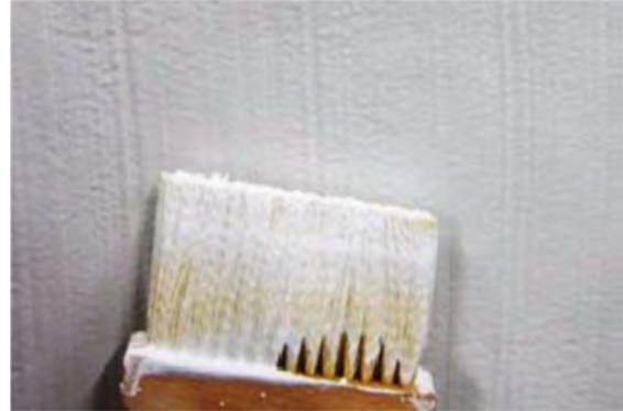
Auftrag von MasterSeal 6100 FX mit Pinsel
