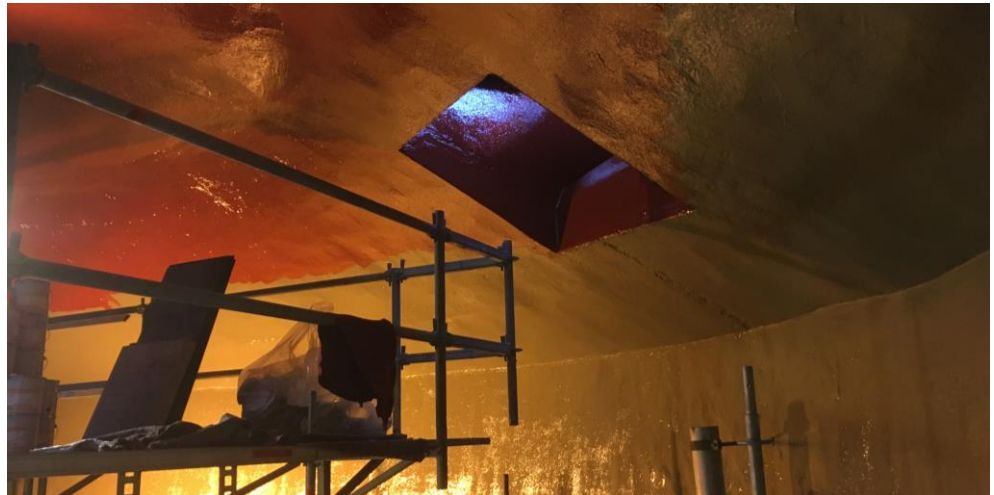
Rådnetanken renoveres med MasterSeal 7000 CR
