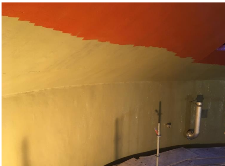
MasterSeal M 790 påføres á 2 gange - først i gråt derefter i rødt.
