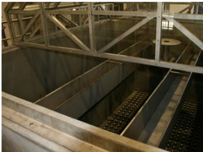
MasterEmaco S 5400 og MasterSeal 531 er anvendt til både de underjordiske vandtanke og inddæmningen af rensningsanlægget inde i selve bygningen
