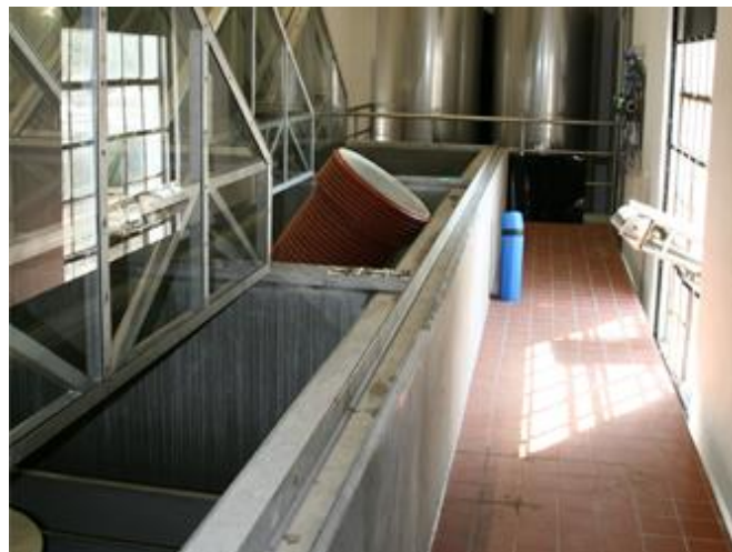
MasterEmaco S 5400 og MasterSeal 531 er anvendt til både de underjordiske vandtanke og inddæmningen af rensningsanlægget inde i selve bygningen
