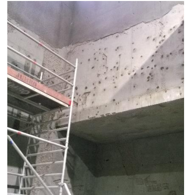
Betonreparationer og udfyldning af klamshuller med MasterEmaco N 5200.
