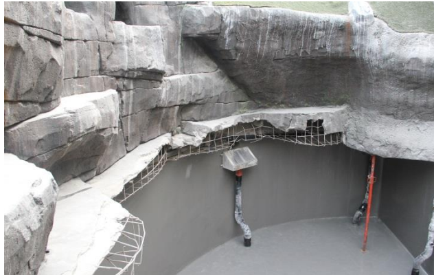
Vandtætning af bassinerne (her Fuglefeldet) er foretaget med drikkevandsgodkendt membransystem MasterSeal 6880.
