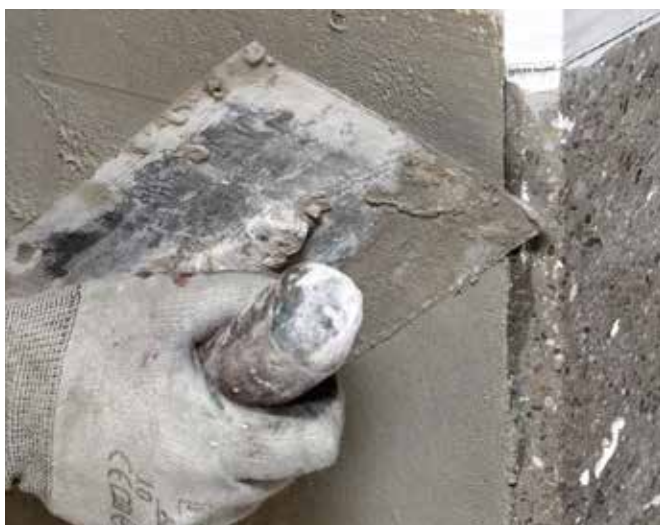
Udjævning af overflade med MasterEmaco N 5100 FC
