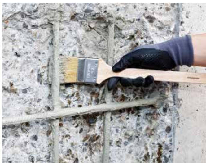
Påføring af MasterEmaco P 5000 AP på rengjort armering
