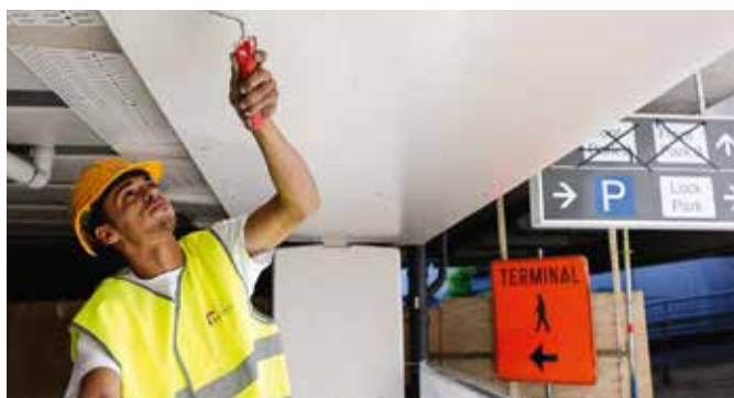
Manuel påføring af MasterProtect 330 EL (Parkeringsanlæg i Bruxelles lufthavn, Belgien)
