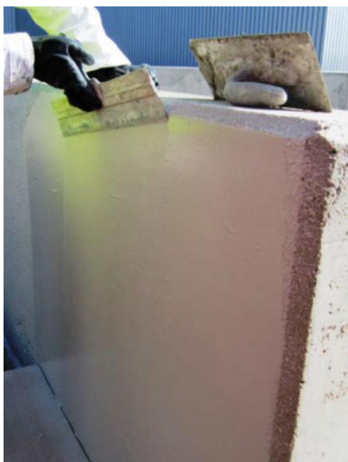
Billede 3: Efterbehandling af MasterSeal 6100 FX
