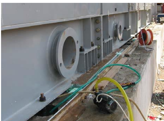
Mætning og dræning af det overskydende vand i ankerhullerne i turbinefundamentet før understøbning.
