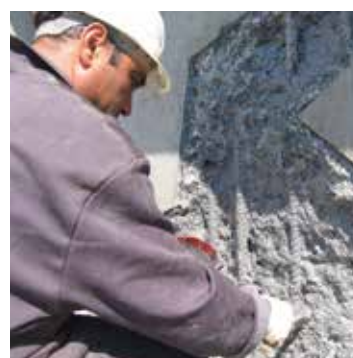
Princip 11, metode 11.1 Aktiv korrosionsbeskyttelse af armeringen med MasterEmaco aktiv primer.
