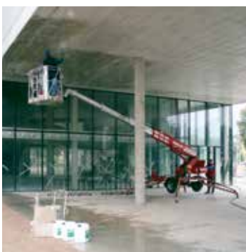
Princip 8, metode 8.1 Vandtætnende behandling med MasterProtect .
