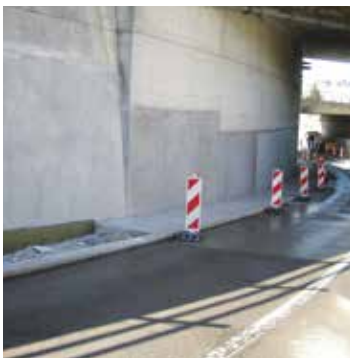
Princip 7, metode 7.2 MasterEmaco bruges til at erstatte kloridforurenset beton.
