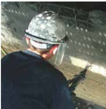
Princip 7, metode 7.1 Øgning af armeringslaget med sprøjtepåført MasterEmaco .
