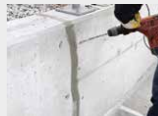
Der bores skråt ind imod revnens forløb fra skiftevis højre og venstre.
