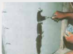
Revnerne spartles til med f.eks. MasterSeal 590.
