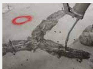
Er der tale om hulrum under slidlag, bores et antal huller ned til det sunde underlag.
