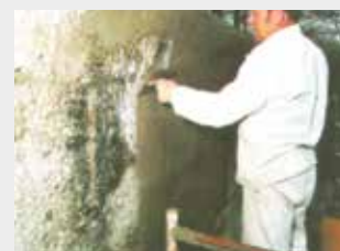
Efter en vellykket injicering kan den videre renovering foretages.
