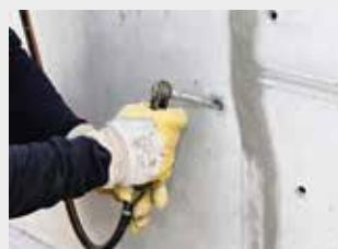
Niplerne monteres i borehullerne.
