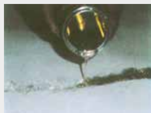
Ved vandrette revner med en bredde over 0,5 mm hældes MasterInject 1360 direkte i revnen
