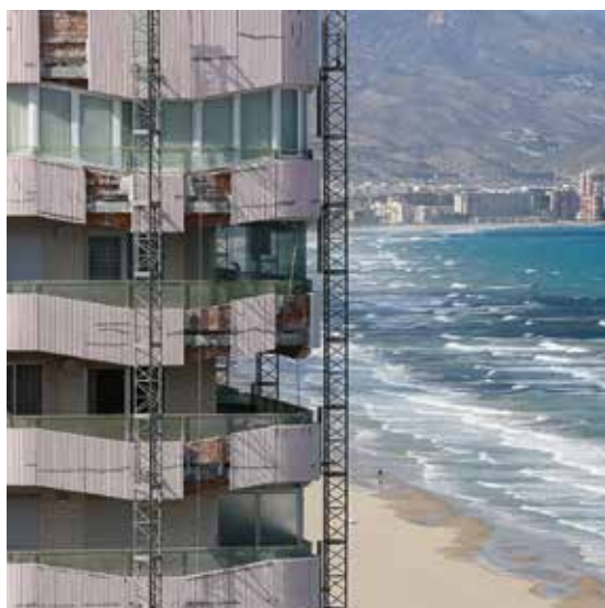
Princip 1: Beskyttelse mod kloridangreb. Torres Blancas, Alicante, Spanien: Beskyttelse med korrosionsinhibitoren MasterProtect.
