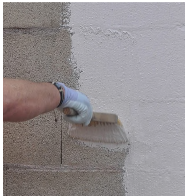
Obr. 1: Aplikace MasterSeal 560 tvrdým štětcem
