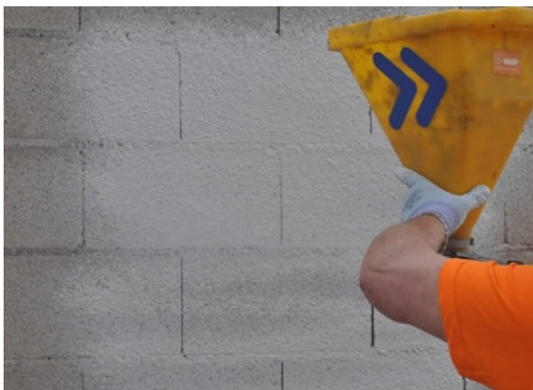
Obr. 2: Strojní nástřik MasterSeal 560
