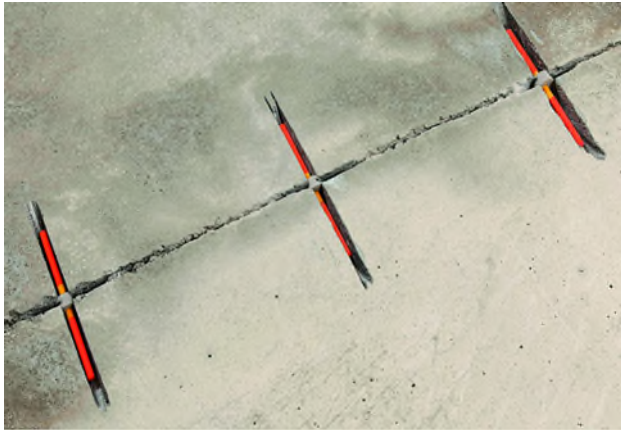
Obrázek 3: Vložení trnů do zářezů vytvořených kolmo na trhlinu.
