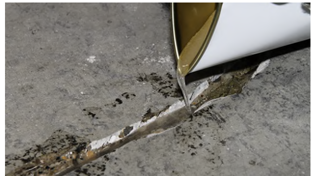
Obrázek 4: Zalévání MasterInject 1360 přímo do žlábků tvaru V, vytvořeném vyříznutím v podélném směru trhliny.
