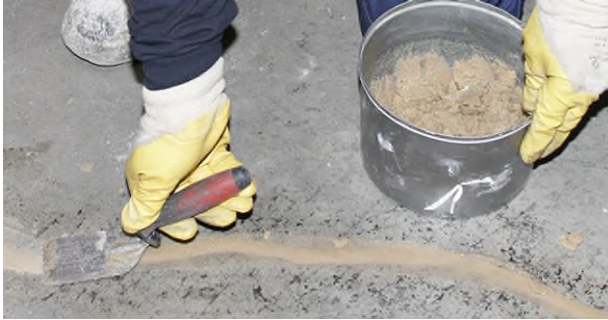
Obrázek 5: Finální zarovnání povrchu trhliny epoxidovou maltou.
