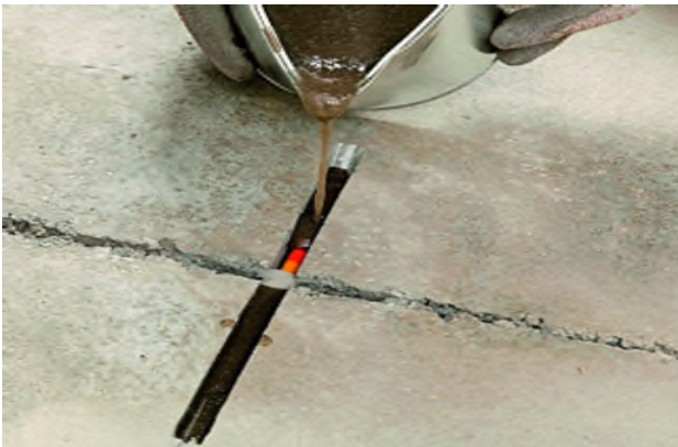
Obrázek 6: Zalévání vložených trnů v zářezech namíchanou pryskyřicí MasterInject 1360 s pískem.
