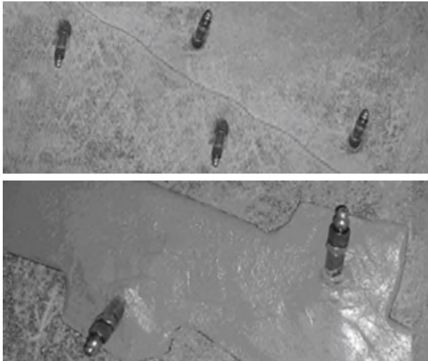
Obrázek 1: Vrtané pakry střídavě umístěné kolem trhliny, jejíž povrch je utěsněn epoxidovým lepidlem MasterBrace ADH.
