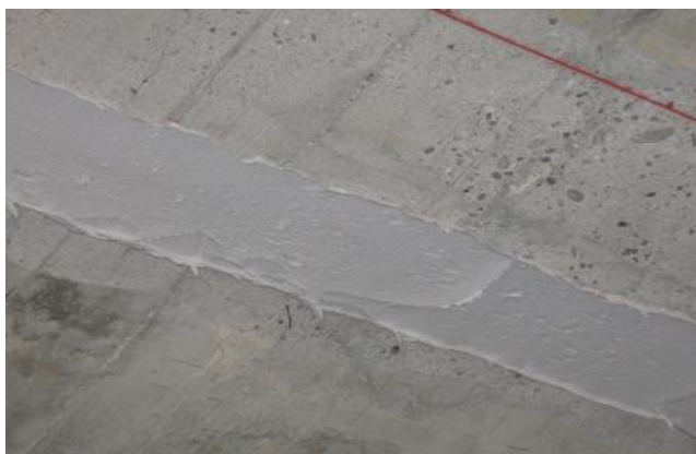
Obr. 2. MasterBrace ADH 4000 se aplikuje na betonový podklad za pomoci ocelové špachtle.
