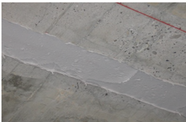
Obr. 2. MasterBrace ADH 3000 se aplikuje na betonový podklad za pomoci ocelové špachtle.
