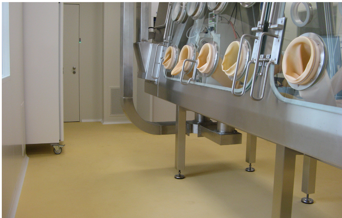
Naše reference v Neratovicích (CZ): Cayman Pharma s.r.o., Neratovice – rekonstrukce laboratoří
