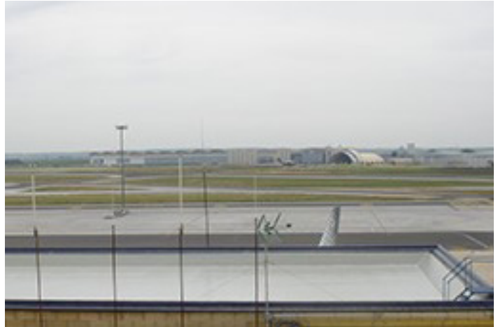
Impermeabilización mediante Sistema MasterSeal roof 2103
