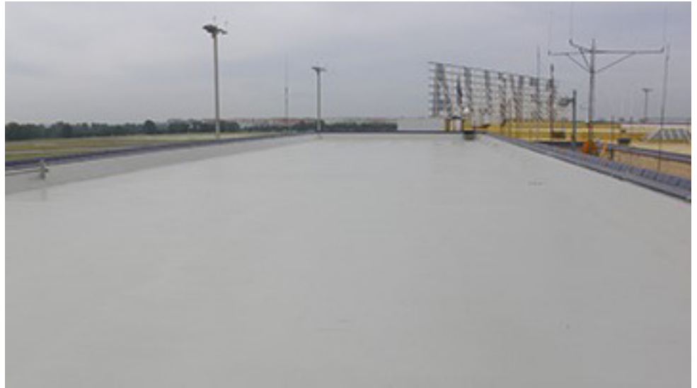
Sistema MasterSeal Roof 2103 en cubierta Aeropuerto de Sevilla
