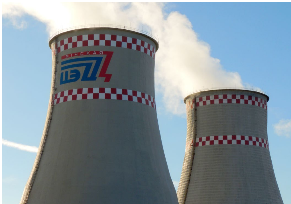
Объект: Железобетонная гиперболическая градирня, РУП «Минскэнерго», г. Минск
