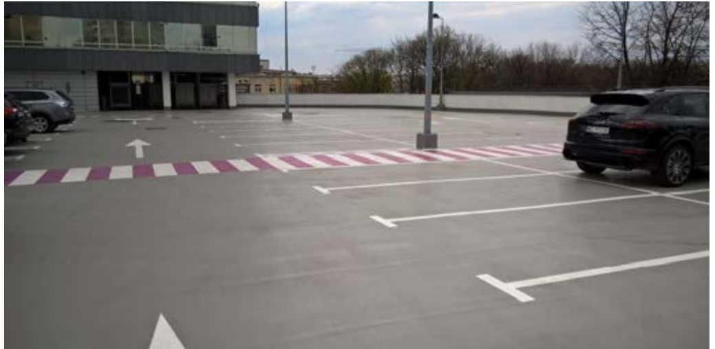
Wygląd wykonanej powłoki parkingowej MasterSeal Traffic 6689
