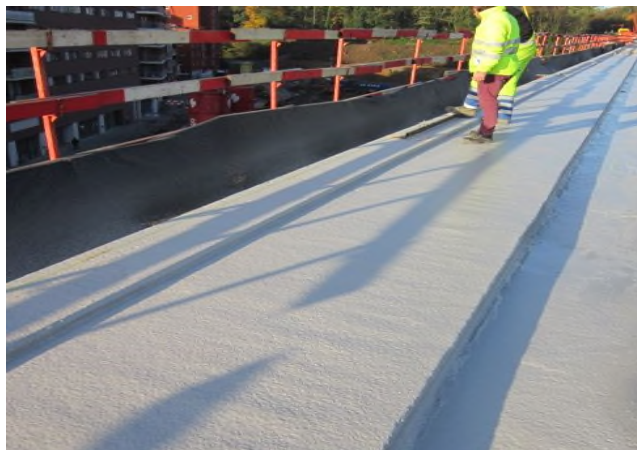
La nostra referenza a Leuven (Belgio): Circonvallazione Leuven: impermeabilizzazione dei marciapiedi
