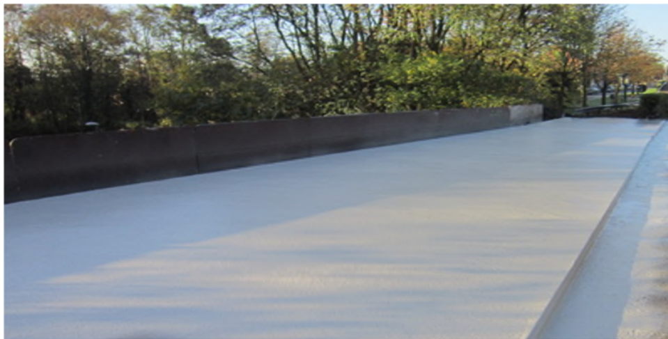
La nostra referenza a Leuven (Belgio): Circonvallazione Leuven: impermeabilizzazione dei marciapiedi
