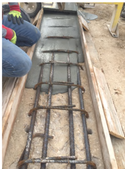
Colaggio dall'alto del MasterEmaco S 475 PG
