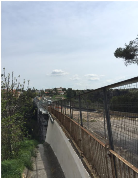
Visuale del ponte durante le fasi di posa del MasterEmaco
