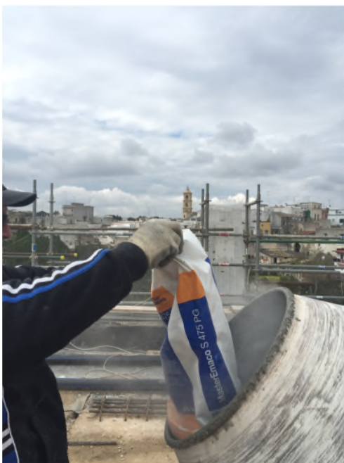
Una fase della miscelazione in betoniera da cantiere di MasterEmaco S 475 PG
