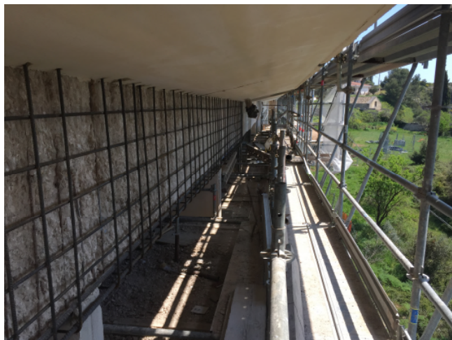
Il supporto preparato con ancorate le nuove armature
