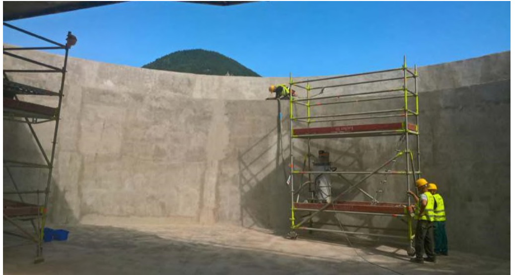
Sanierung und Abdichtung eines Tanks
